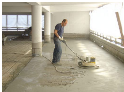
Bild 19. Einbettung des Anodensystems in den KKS-Mörtel Fig. 19. Embedding the anodes in anode mortar
