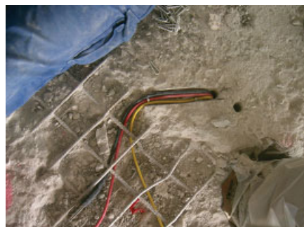
Bild 17. Einbau der Bewehrungs- und Anodenanschlüsse sowie der Referenzelektroden; die Platzierung der Referenzelektroden wurde vor dem Einbau ausgemessen Fig. 17. Mounting of the connections to reinforcement and anodes, and reference anodes
