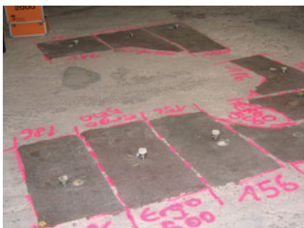
Bild 16. Kontrolle der Haftzugswerte und Aufbringen der mineralischen Ausgleichsschicht
