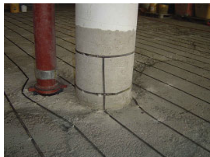
Bild 18. Anbringen des Anodensystems auf die Betonoberfläche Fig. 18. Application of the anodes on concrete surface
