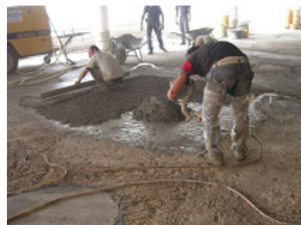
Bild 16. Kontrolle der Haftzugswerte und Aufbringen der mineralischen Ausgleichsschicht
