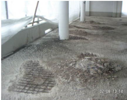
Bild 14. Abstemmen des minderfesten Konstruktionsbetons
