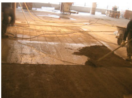
Bild 19. Einbettung des Anodensystems in den KKS-Mörtel Fig. 19. Embedding the anodes in anode mortar
