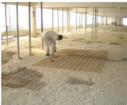
Bild 15. Verstärkungsarbeiten an der Bewehrung
