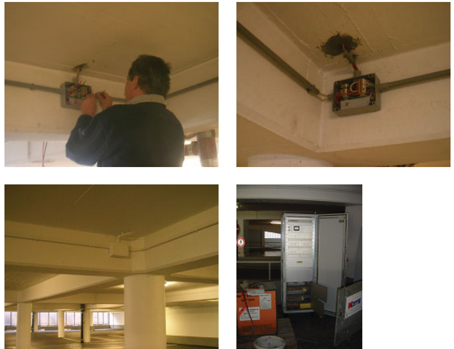
Bild 21. Elektroinstallation und Gleichrichtermontage Fig. 21. Electrical installation with rectifier
