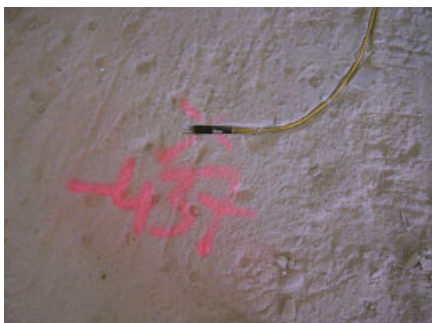
Bild 17. Einbau der Bewehrungs- und Anodenanschlüsse sowie der Referenzelektroden; die Platzierung der Referenzelektroden wurde vor dem Einbau ausgemessen Fig. 17. Mounting of the connections to reinforcement and anodes, and reference anodes
