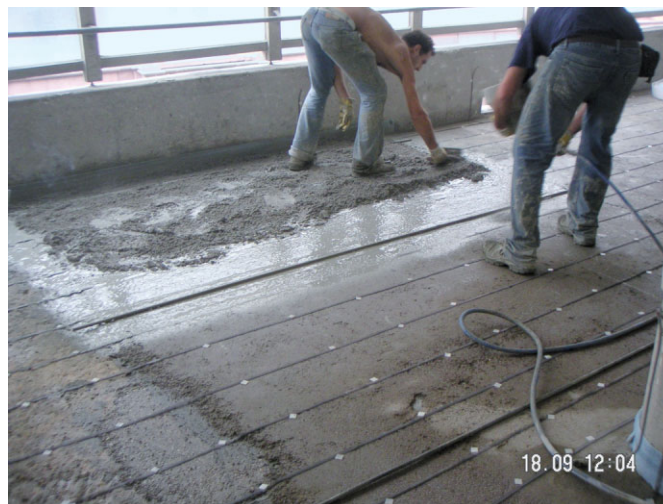
Bild 10. Applikation des Anodeneinbettmörtels
