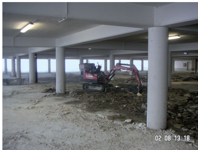
Bild 6. Entfernen des Verbundestrichs Fig. 6. Removal of the screed
