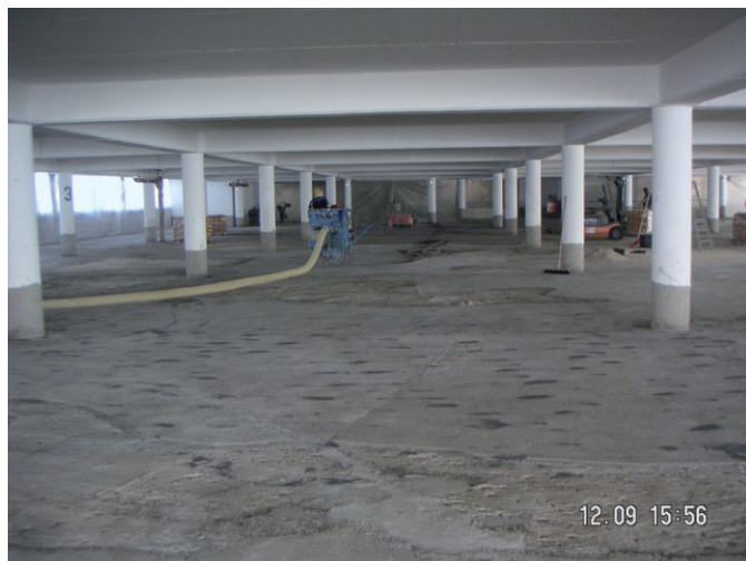
Bild 8. Für die Applikation der Anoden vorbereiteter Betonuntergrund
