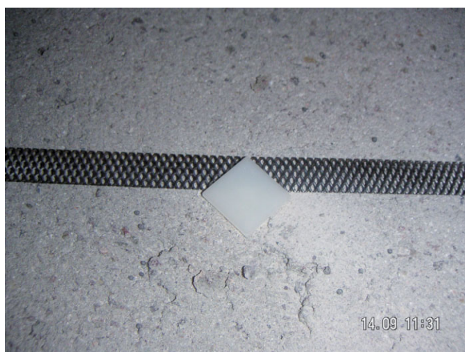
Bild 9. Fixierung der Anodenbänder auf dem Betonuntergrund mit Hilfe von Kunststoffdübeln
