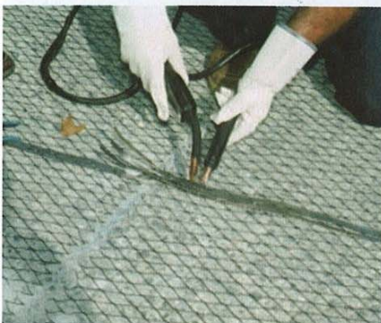
Abb. 3.: Verschweißen der Primäranoden mit dem Titannetz
