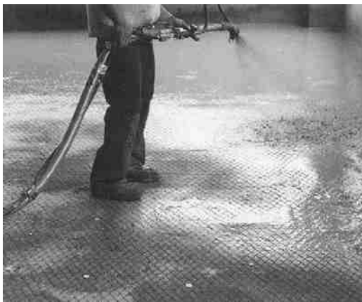
Abbildung 4: Aufbringen des Einbettmörtels
